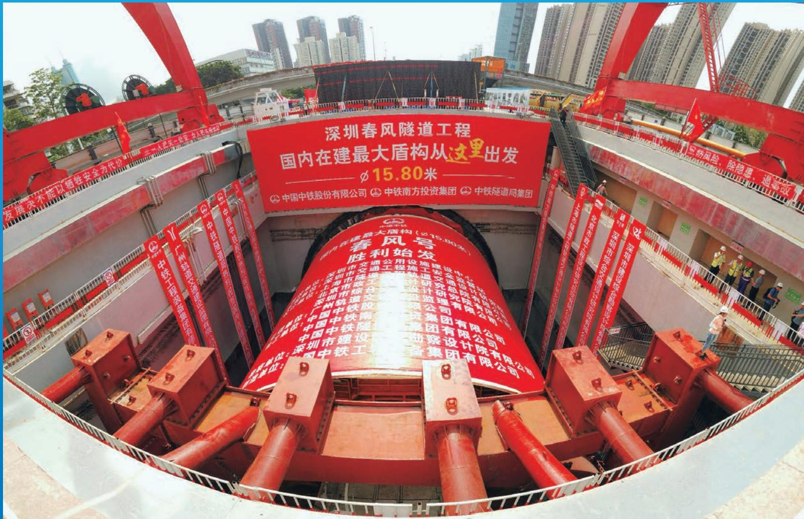
春风隧道位于深圳市老城区,是粤港澳大湾区和先行示范区建设重点交通项目之一,也是深圳首座采用盾构法施工的市政公路隧道。线路全长 5.078 km,隧道长 4.82 km,盾构段长 3.603 km,采用我国迄今为止自主研发的最大直径(刀盘直径 15.80 m)泥水平衡盾构“春风号”施工。该设备由《隧道建设(中英文)》常务理事单位中铁工程装备集团研制,全长 135 m,总质量达 4 800 t,刀盘厚 2.8 m、质量达 650 t(含刀具),是常规地铁盾构刀盘质量的12倍,装机总功率超过 1.15万 kW,最大推力 2.46万 t。该隧道由中国中铁股份有限公司/中铁隧道局集团施工,盾构于 2019 年 8 月 13 日顺利始发,计划于 2021 年底完工。
