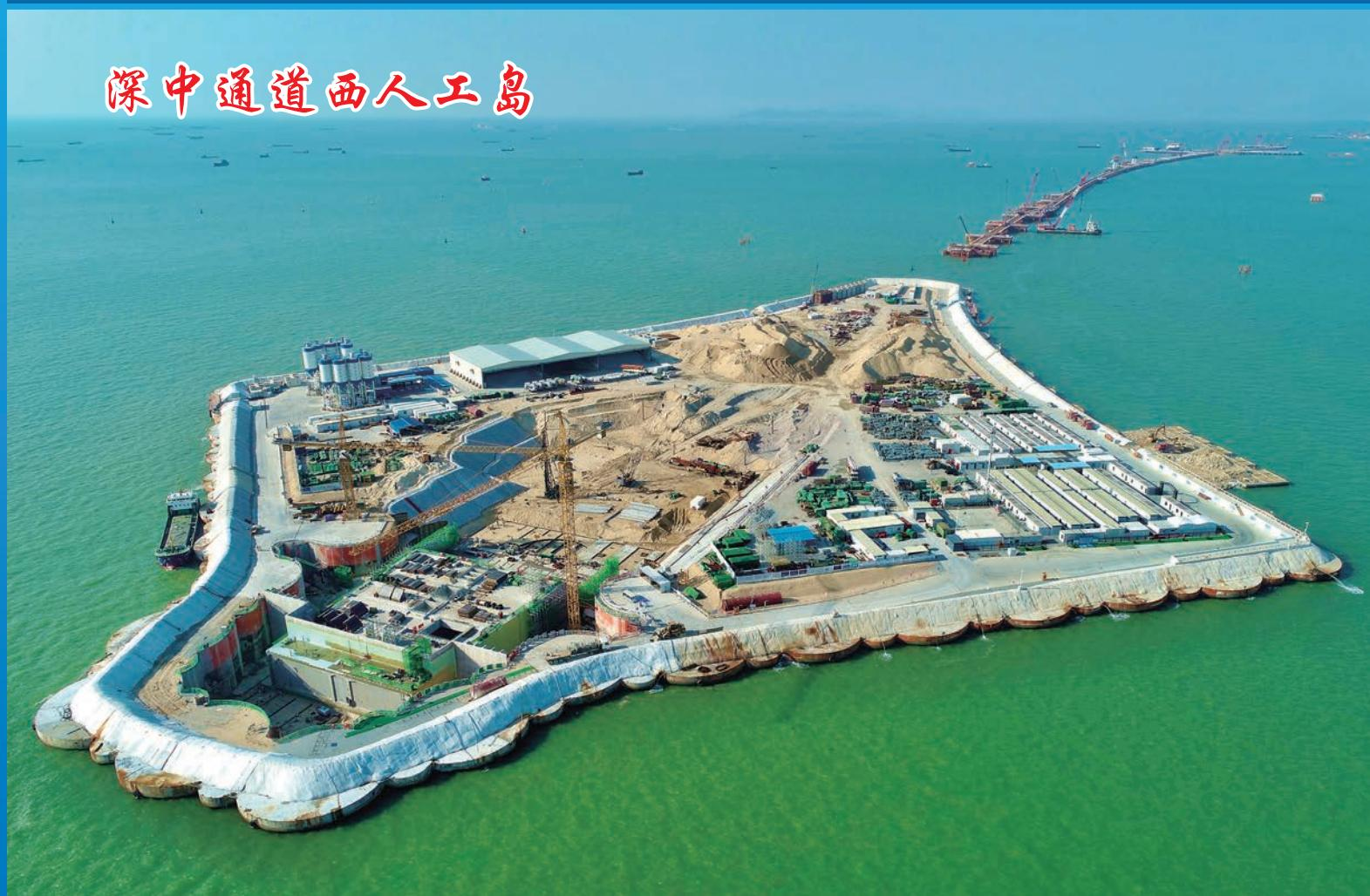
深中通道位于粤港澳大湾区核心战略区域，北距虎门大桥 30 km，南距港珠澳大桥 38 km，是国高网 G2518（深圳至广西岑溪）跨珠江口关键性控制工程，也是“十三五”国家重大工程。线路全长 24.0 km，起自深圳机场互通立交，经广深沿江高速二期，东接机荷高速，向西跨越珠江口，依次设置东人工岛、机场枢纽互通立交、海底沉管隧道（隧道长 6 845 m，沉管段长 5 035 m，共计 32 个管节）、西人工岛、伶仃洋区非通航孔桥、伶仃洋大桥（主跨 1 666 m 海中悬索桥）等，最后在中山马鞍岛登陆，与在建的中开高速对接。项目概算总额 446.9 亿元，其中建安费 352.3 亿元，预计 2024 年完工。
