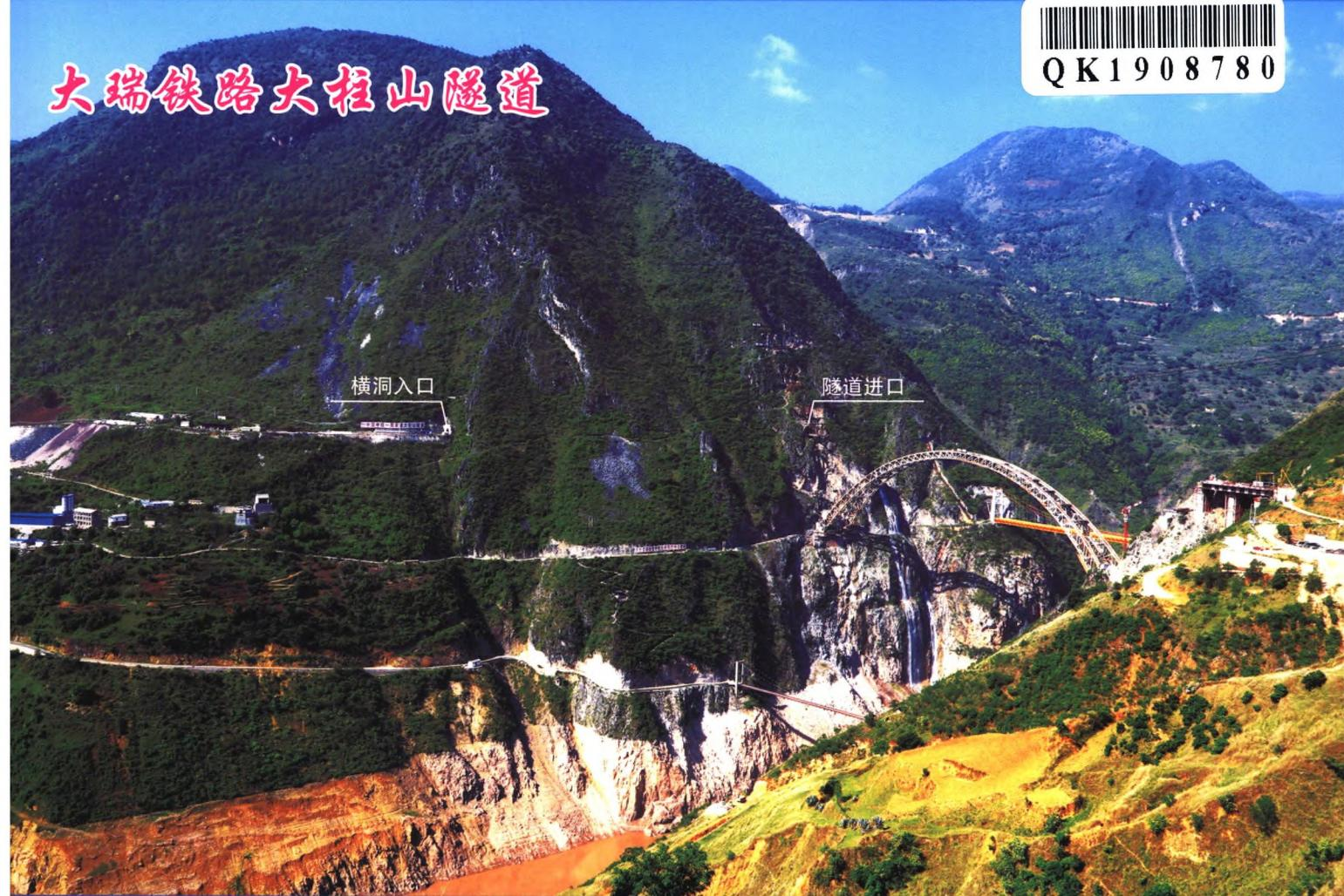
大理至瑞丽铁路是我国第一条穿越横断山脉的国家Ⅰ级干线铁路，桥隧比76.9%，被国内外专家认为是“目前国内艰险山区地形地质条件最为复杂的线路”。由中铁一局集团有限公司施工的大柱山隧道为大瑞铁路大理至保山段一座极高风险隧道，全长14.484 km，最大埋深为995 m。隧道地质复杂多变，穿越6条断裂带、5处岩溶发育地段、3条皱褶构造。隧道进口地处悬崖峭壁，施工时在左侧山腰处开凿了1个横洞，再向两侧分头开挖。受地形条件限制，无法设置竖井、斜井，通过平导辅助正洞施工。2008年8月8日开工至今，历时近11年，先后克服突泥涌水（总涌水量达1.4亿m<sup>3</sup>，相当于10余个西湖的水量，最大涌水量达12万m<sup>3</sup>/d）、瓦斯、软弱围岩大变形、断层、高地温、岩爆等地质灾害，并成功解决单线铁路隧道独头掘进8 km长距离通风和长5.5 km、水量8万m<sup>3</sup>/d岩溶段反坡排水施工难题，预计在2019年6月贯通。
