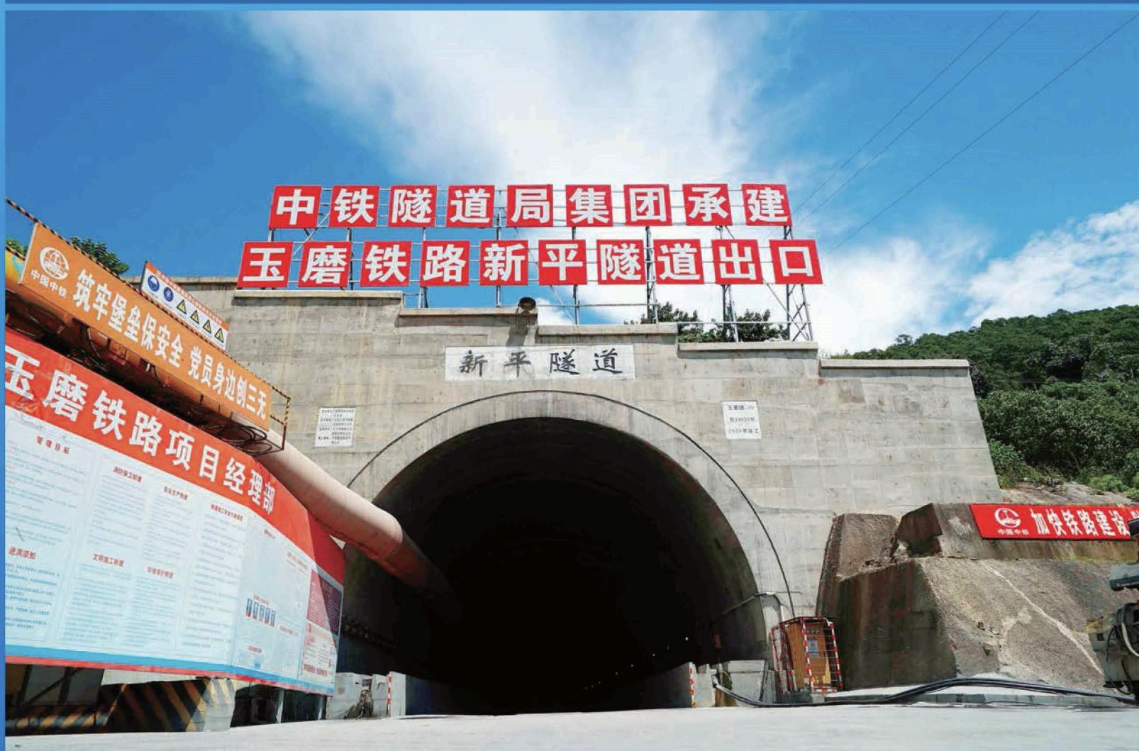
玉溪至磨憨铁路位于云南省南部，是泛亚铁路中线的重要组成部分，也是“一带一路”重点工程。由中铁隧道局集团承建的站前工程YMQ-3标线路全长 26.78 km，含“四隧三桥”，其中，隧道总长 25.38 km，占标段长度的 94.77%，包括新平（长 14.835 km）、立新、月牙田 3 座 I 级高风险隧道。穿越多条断层破碎带，地质构造极为复杂，洞身断裂、褶皱、节理裂隙极其发育，岩体极为破碎，遇水泥化严重，极易发生涌突、溜坍、大变形等不良地质灾害。2016 年 4 月开工至今，隧道累计发生突水、涌泥（砂）28 次，涌泥（砂）量约 6.4 万 m<sup>3</sup>（单次最大涌突量 1 万 m<sup>3</sup>），最大涌水量 1 175 m<sup>3</sup>/h；发生溜坍 413 次，溜坍量达 5.6 万 m<sup>3</sup>。采用三台阶（预留核心土）带仰拱一次开挖工法、铣挖机非爆开挖等施工技术，极大程度降低了不良地质灾害发生的频次。
