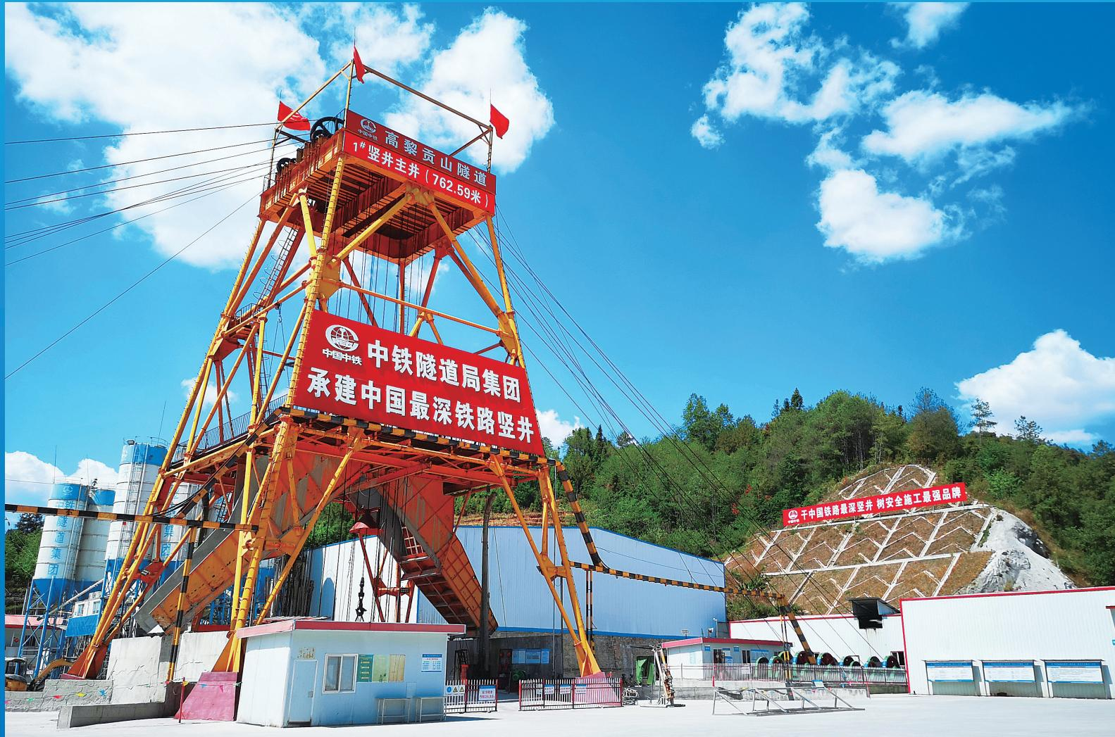
高黎贡山隧道全长34.538 km, 最大埋深1 155 m, 平均埋深800 m, 隧道所处区域具有“三高、四活跃”特征。为加快施工进度、解决施工及运营过程中的通风问题,于洞身中部设置1#竖井。1#竖井采用主、副井设置方式,主井、副井深分别为762.59、764.79 m, 为国内同类工程最深竖井。竖井施工引用机械化快速施工理念,采用普通凿井法,配备大型专业化机械,形成了机械化开挖系统、出碴系统、悬吊系统、绞车提升系统等“四系一体”的机械化流水线,实现了打眼、爆破、出碴、模板安装、混凝土浇筑等全流程机械化作业。为克服竖井围岩纵向节理发育、突泥涌水、富水花岗岩等地质难题,采用“探、注、掘”相结合的系统治理措施,大大减小了施工风险。该竖井工程由中铁二院设计、中铁隧道局施工。
