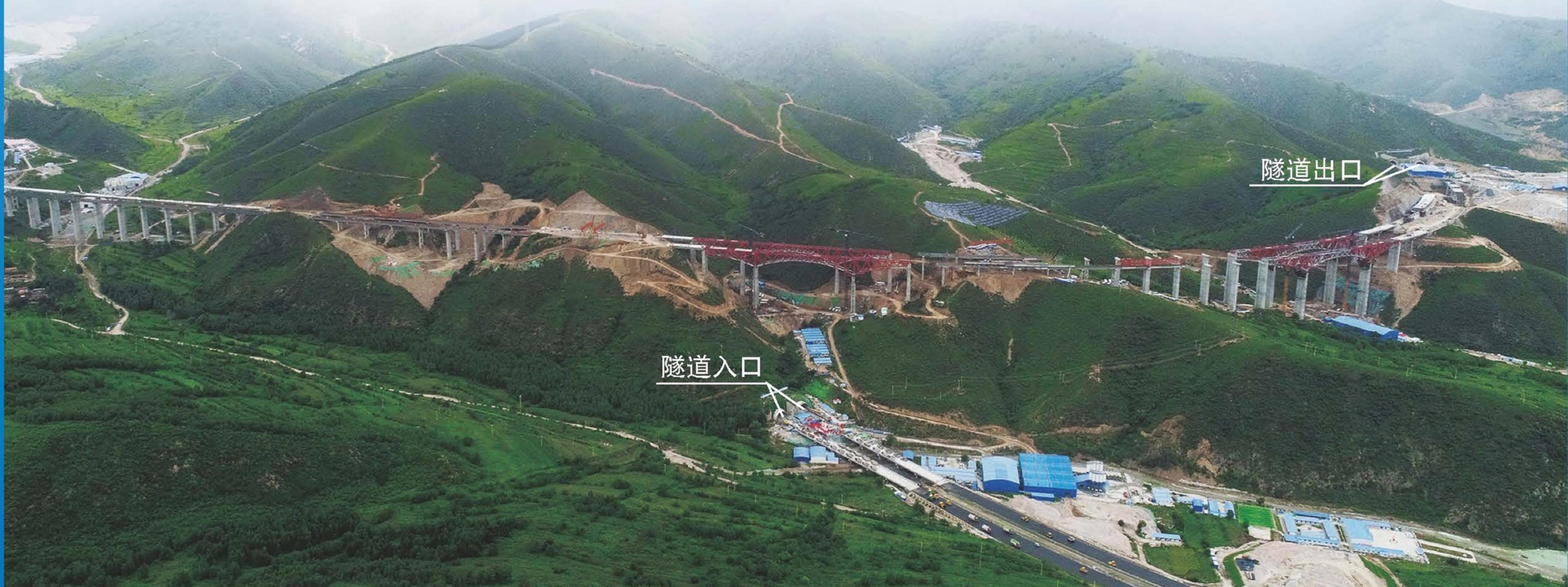
延庆至崇礼高速公路是 2022 年冬奥会中连接延庆赛区和张家口赛区的重大交通保障项目，金家庄螺旋隧道是延崇高速公路河北段最重要的控制性工程，也是世界上最长的公路螺旋隧道（获吉尼斯世界纪录）。该隧道为双洞分离式特长隧道，全长 4.2 km，进口和出口高差达 80 余 m，曲线半径 860 m，隧道通过螺旋展线（270°）把纵向坡度降至 1.91%，实现原地抬升 112 m，完美地解决了线路爬升及避开地质不良地段的难题。该隧道由河北省交通规划设计院设计，四川公路桥梁建设集团有限公司施工，预计在 2019 年 9 月上旬全线贯通。
