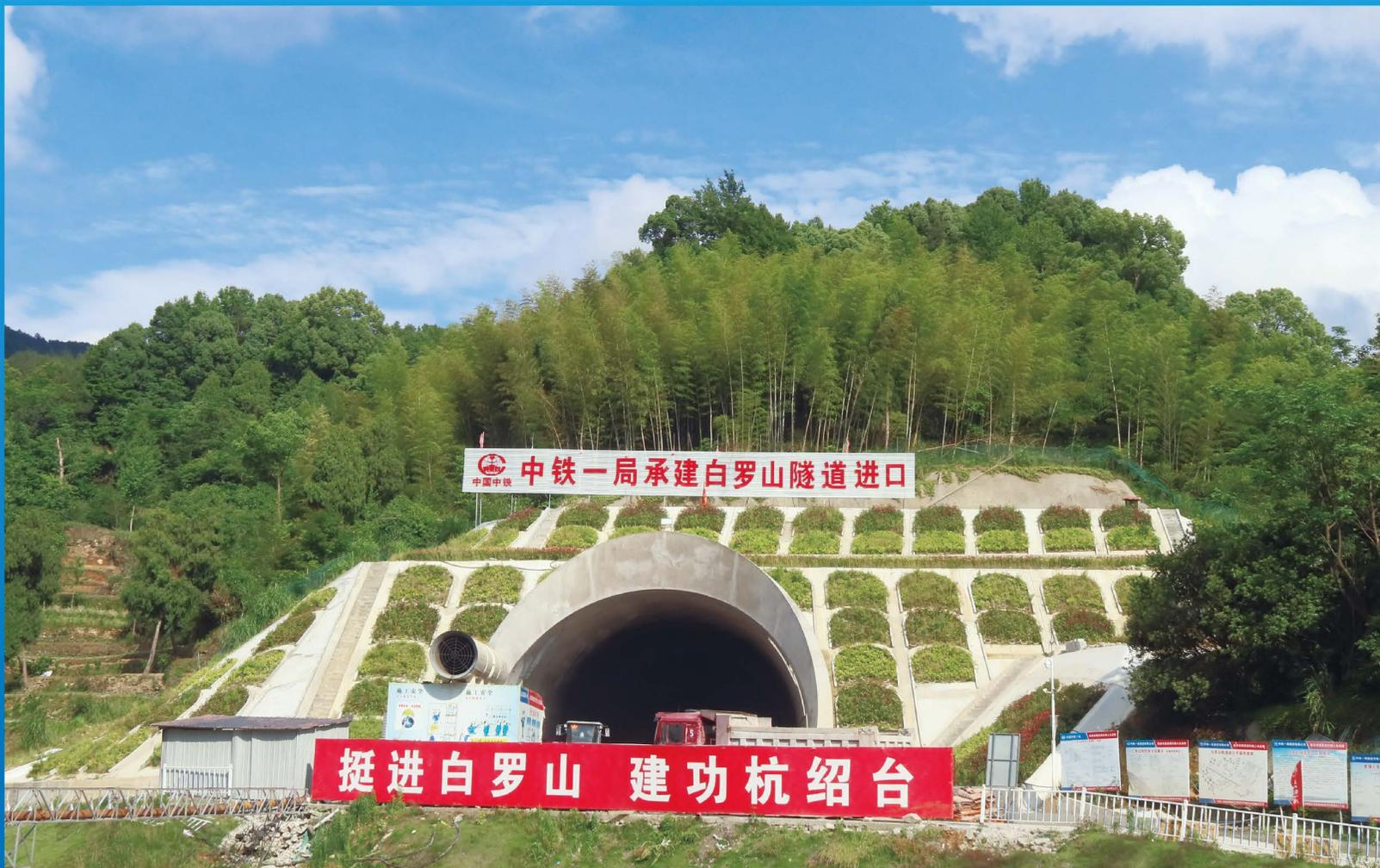
杭州经绍兴至台州城际铁路线路全长 266 km, 建成后浙江省可实现“1 h 交通圈”。由中铁一局集团有限公司承建的白罗山隧道是杭绍台城际铁路首座贯通的万米特长高风险隧道, 全长 10 006 m, 最大埋深 408 m。隧道地质复杂, 穿越 14 条断层, 围岩破碎松散, 易发生坍塌、岩爆等灾害, 并伴有涌水(最大涌水量达 45 000 m<sup>3</sup>/d)、高地温热害(最高温达 43 ℃)等。施工中, 采用水压爆破、大型混凝土喷射机械手、自动喷淋养护台车等工艺和工装, 采取大直径风管加强送风、冰块降温等措施, 有效减少了超欠挖, 克服了涌水、高地温、断层、岩爆等不良地质, 斜井开挖进度达 242 m/月, 正洞单口掘进速度达 228 m/月。该隧道 2018 年 5 月开工, 2020 年 5 月 15 日顺利贯通。
