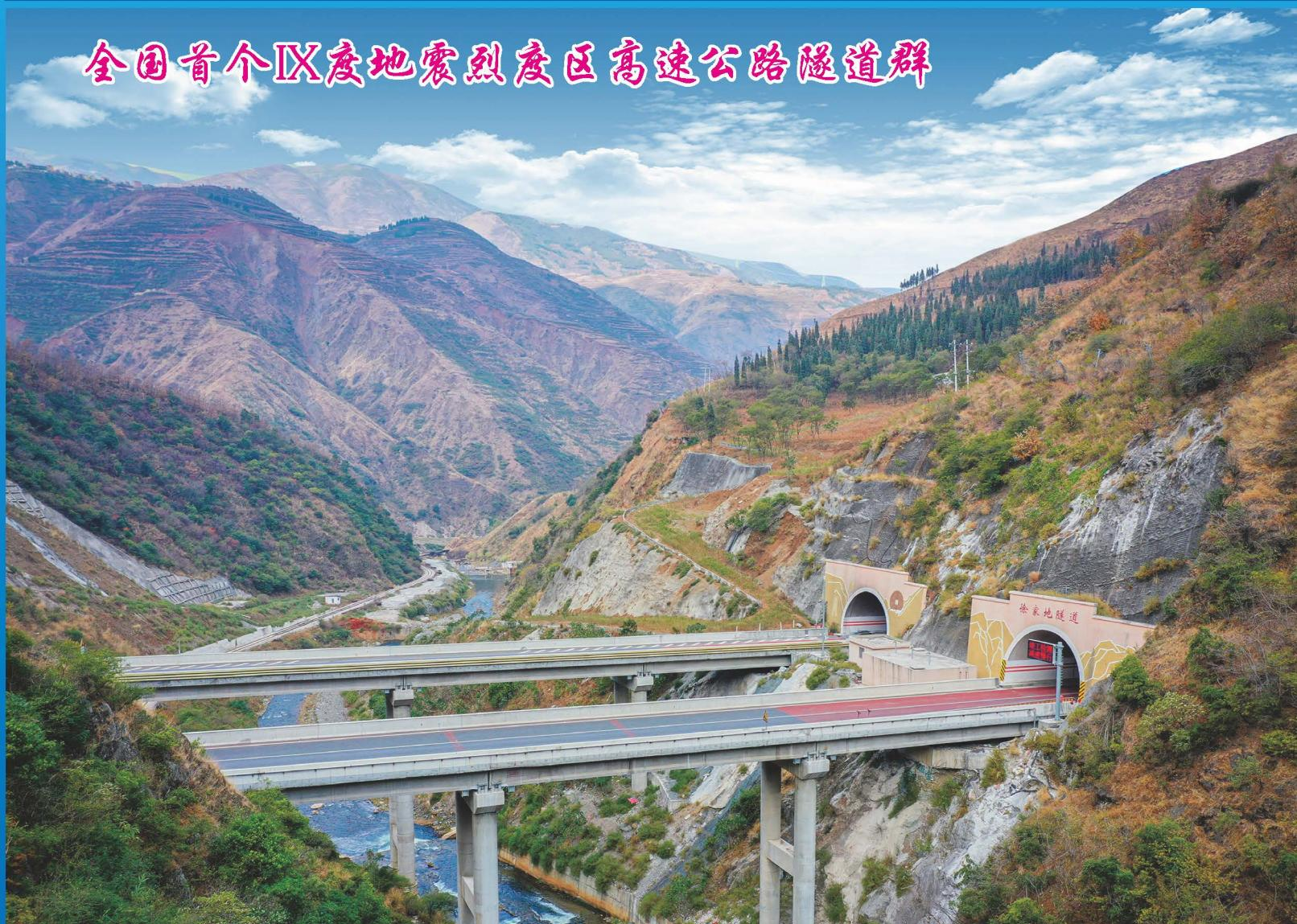
昆明市功山至东川高速公路项目起于G85功山立交互通，止于东川区小龙潭村，全长 49.4 km，为双向 4 车道高速公路，设计行车速度 80 km/h。全线共 12 座隧道，含徐家地隧道（长 3.9 km）和达德隧道（长 3.6 km）2 座特长隧道，隧道总长 18.8 km，桥隧长度占线路总长的 70%。项目全线位于小江活动断裂带影响区，平行于活动断裂东支，距离主断层面最近处仅 300~500 m；主要项目区分布泥石流 26 条、大型滑坡 11 处，是国内首次在 IX 度地震烈度区建设的高速公路特长隧道群。隧道群多次穿越破碎带、断层泥区等不良地质，施工期间突泥、涌水、围岩大变形多发，安全风险极高。该工程由云南省交通投资建设集团投资建设，苏交科集团股份有限公司设计，于 2019 年 1 月 23 日通车。
