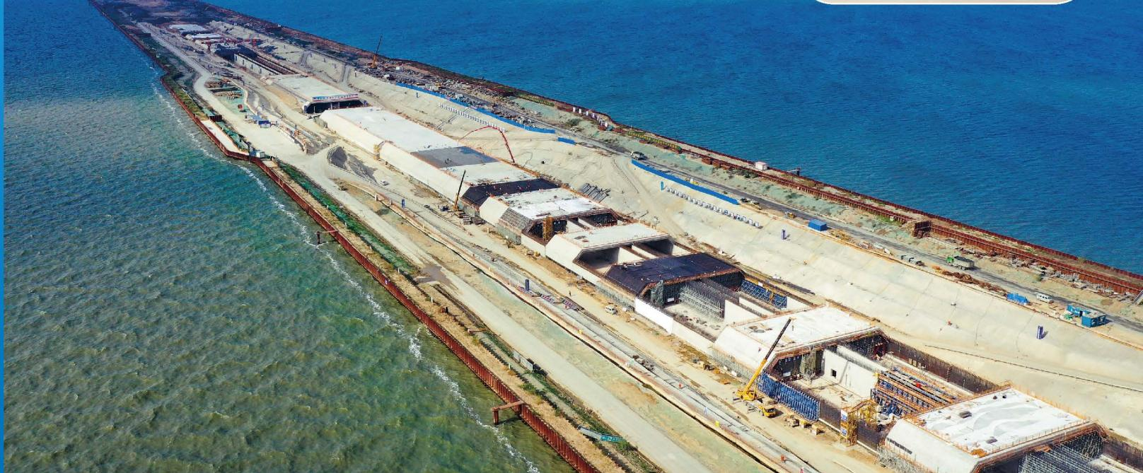
太湖隧道是苏锡常南部高速公路的重要节点工程，采用双向六车道高速公路技术标准，设计行车速度 100 km/h，建设工期 4 年。太湖隧道从无锡马山境内向东穿越太湖梅梁湖，在无锡南泉侧接地，全长 10.79 km，是国内最长的公路水下隧道。主体结构采用折板拱结构，两孔一管廊形式，单孔净宽 17.45 m，横断面总宽约 43.6 m。隧道穿越太湖环境敏感区，主体工程采用堰筑法，具有建设规模大、技术复杂、施工风险高、环保要求严、运营安全保障压力大等特点，其建设难度在行业内屈指可数。该工程由华设设计集团股份有限公司、上海市隧道工程轨道交通设计研究院设计，中交第三航务工程局有限公司、中铁四局集团有限公司施工，预计 2021 年 12 月通车。
