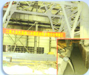
中国二重大压机基础二次灌浆
