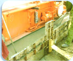
天津大港油田压缩机二次灌浆
