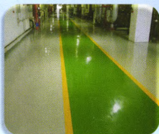
新疆乌苏热电厂车间地面
