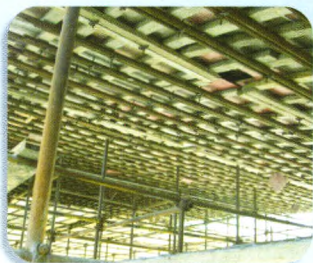
平武拱形大桥底部加固
