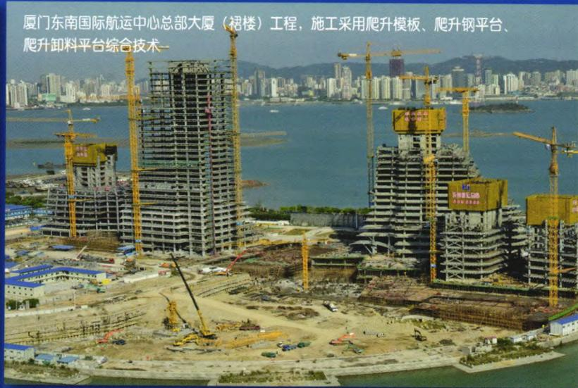
厦门东南国际航运中心总部大厦（裙楼）工程，施工采用爬升模板、爬升钢平台、爬升卸料平台综合技术
