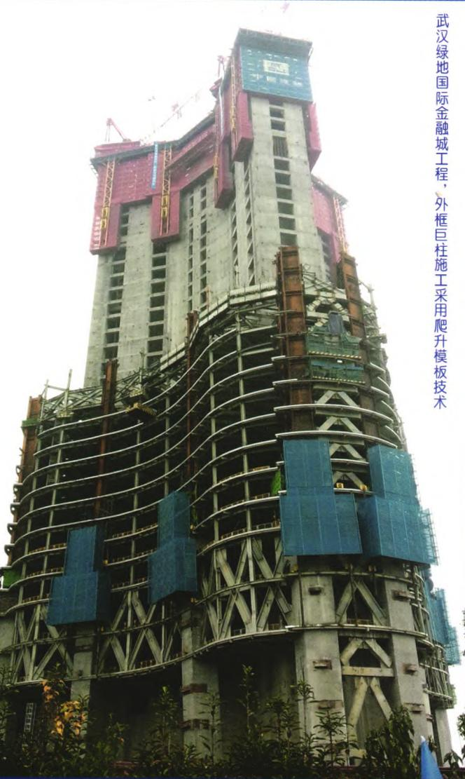
武汉绿地国际金融城工程，外框巨柱施工采用爬升模板技术
