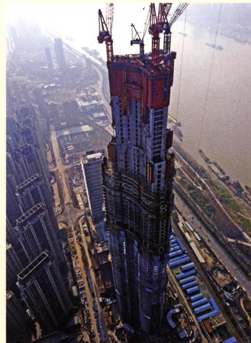
武汉绿地国际金融城工程，建筑高度636米，外框巨柱施工采用新型变角度爬升模板技术
