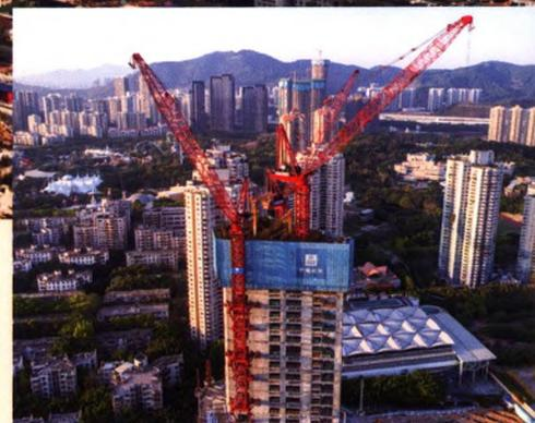
深圳华侨城工程，建筑高度300米，施工中采用新型爬模、液压自爬升逃生梯、组合式电梯井爬升钢平台综合施工技术
