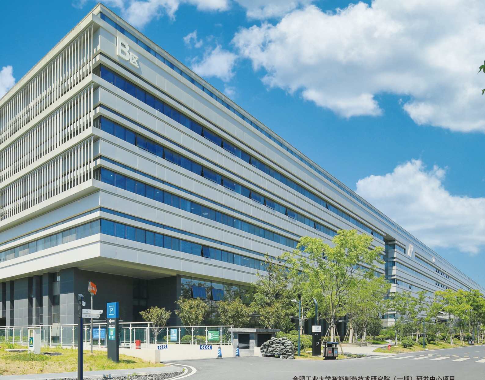
合肥工业大学智能制造技术研究院（一期）研发中心项目 (中国建设工程鲁班奖)
