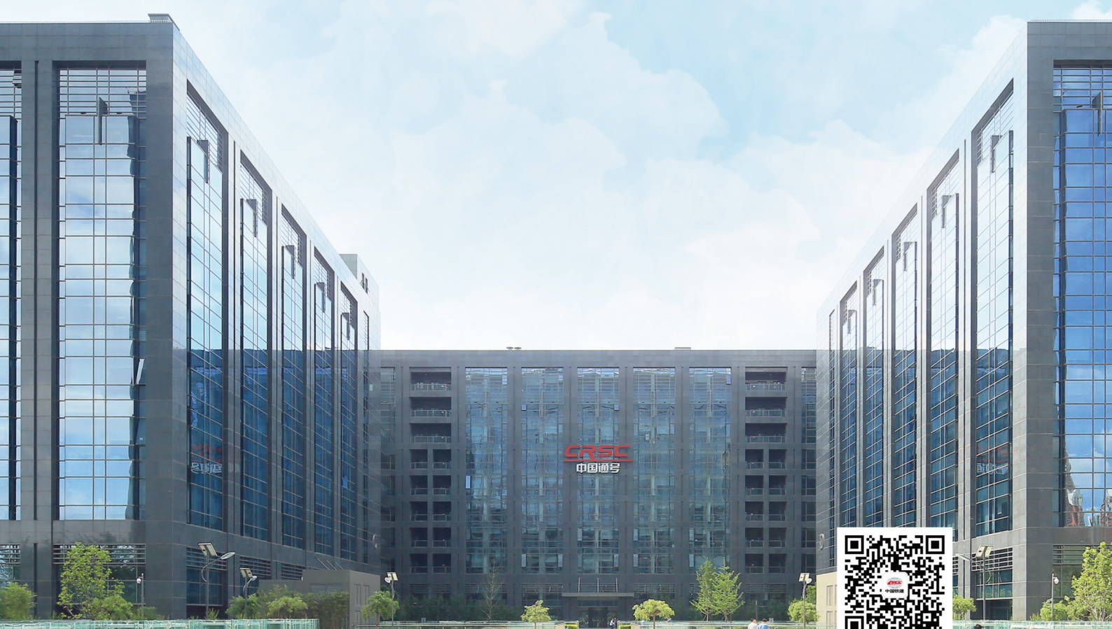
中国通号轨道交通研发中心工程 (中国建设工程鲁班奖)
