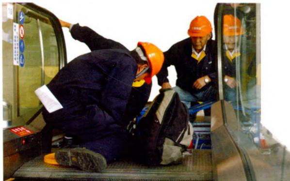
“保持自动扶梯开通,先检查扶手带与梯级的速度和同步率。”“检查‘非操纵逆转保护装置’。”“设备试运行……好,撤掉隔离带,去下一部。”大步流星的王工程师显得格外朴实、严谨。
