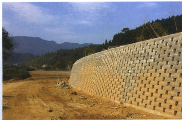
南平顺昌县生态挡墙工程
