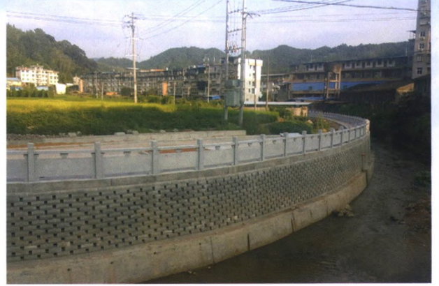
生态挡墙应用于狭窄山区性河道
