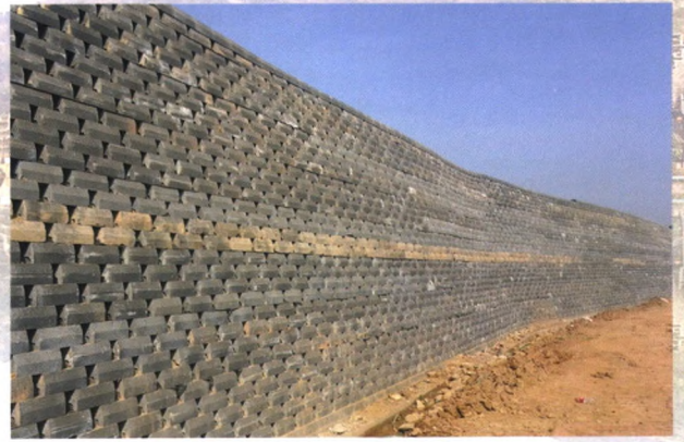
5米高加筋土生态挡墙工程
