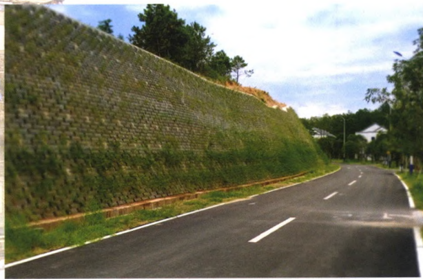
9米高锚杆式生态护面挡墙 - 土体锚固
