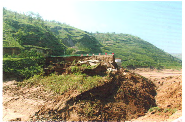
图9 子洲县清水沟水库被冲垮(杨勤科摄于20170730)
