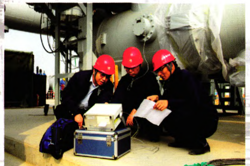
● 特高压现场微水测试
