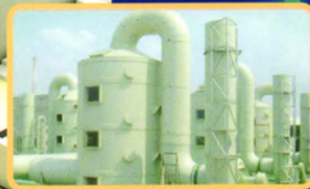
实验室废水废气处理工程
