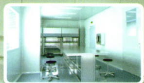
洁净实验室空调智能控制系统
