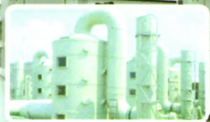
实验室废水废气处理工程
