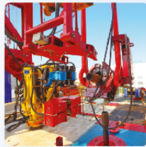
铁钻工、液压吊卡、气动卡瓦
