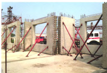
预制墙板安装
