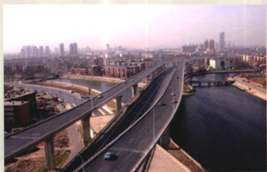
天津西站西纵立交
