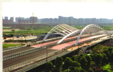
杭州九沙大道桥梁
