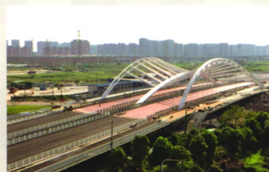
杭州九沙大道桥梁
