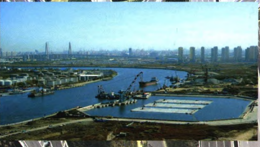
中央大道海河隧道
