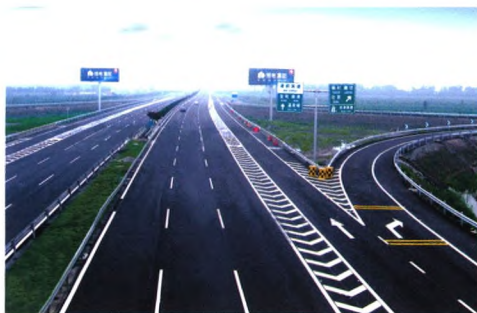
京津高速公路
