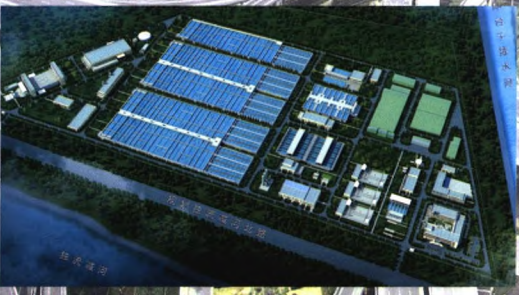
天津咸阳路污水处理厂
