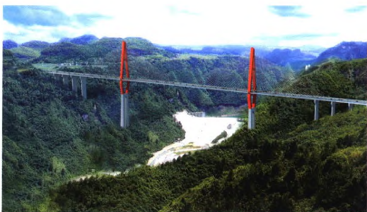
贵州朵花大桥
