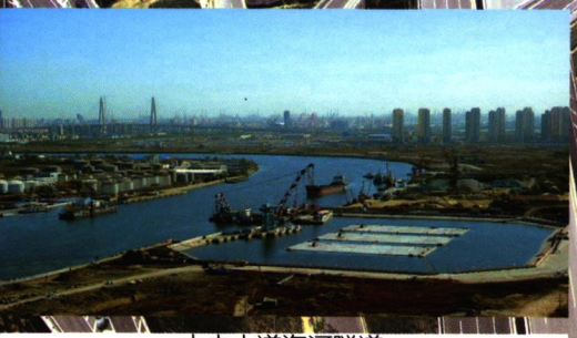
中央大道海河隧道
