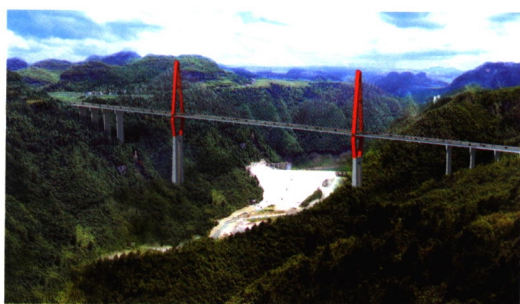
贵州朵花大桥
