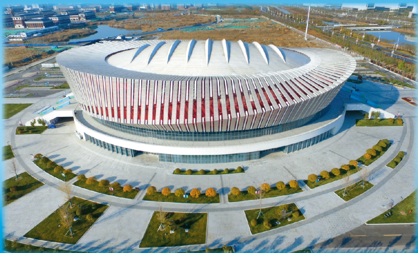
新校区旋衡体育馆(航拍)
