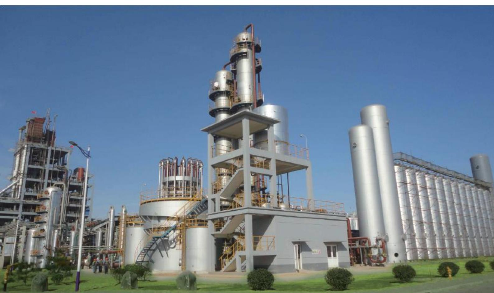
西南化工研究设计院有限公司提供技术的工业排放气合成乙二醇工业装置
