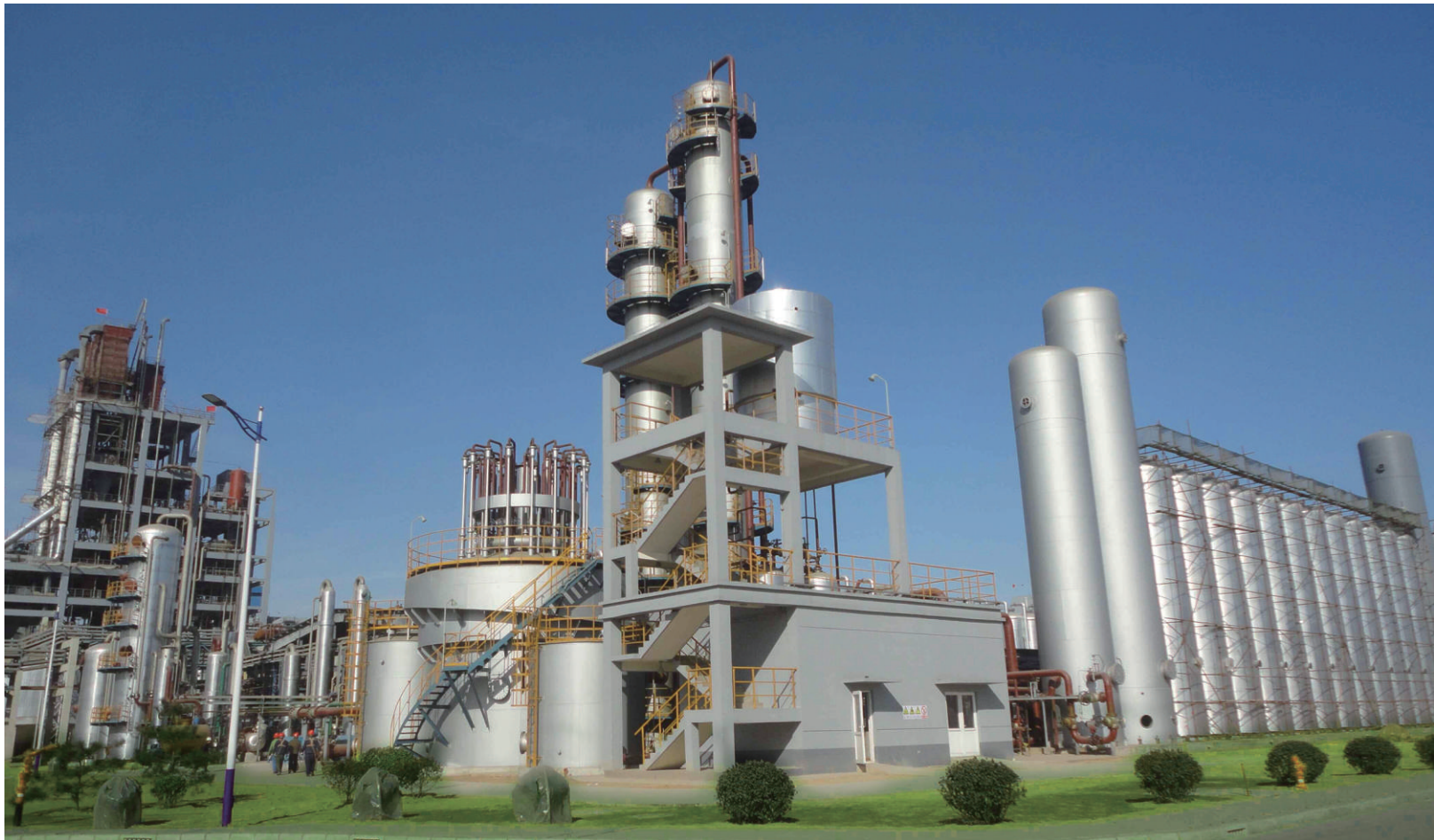
西南化工研究设计院有限公司提供技术的工业排放气合成乙二醇工业装置
