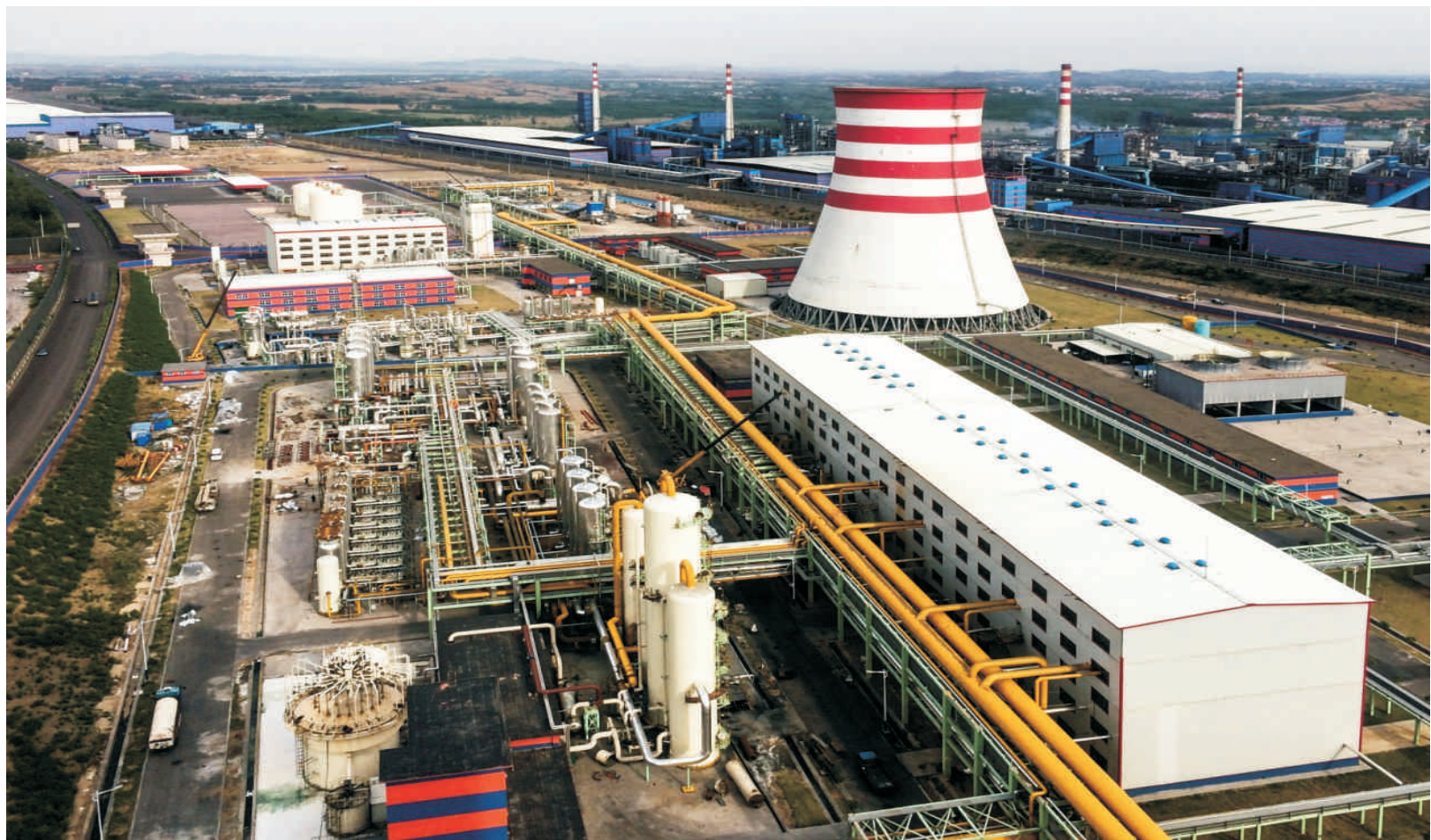
西南化工研究设计院有限公司焦炉煤气甲烷化制LNG装置
