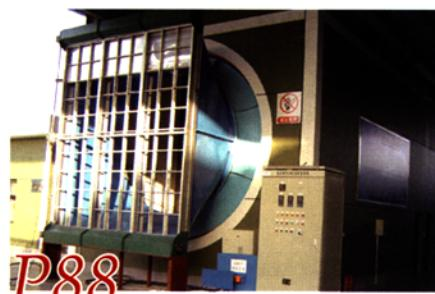
不锈钢幕帘阀在地铁隧道中的应用
