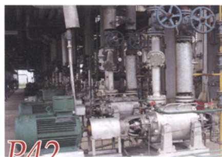
干气密封技术在气分装置原料泵上的开发应用
