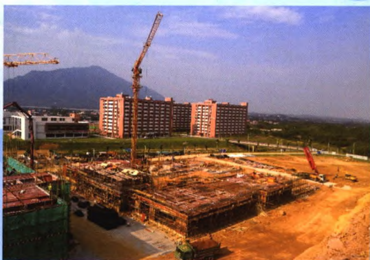
▲ 2020年4月30日,建工集团建设的省职教城清远校区二期工程顺利完成首层板建设目标,建设进入快车道
