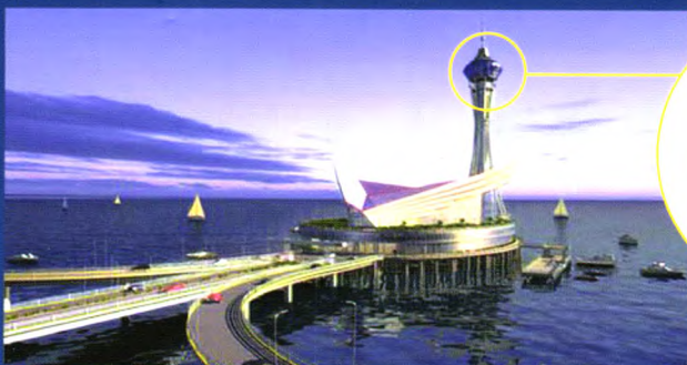
杭州湾观光塔（145m）的抗风振横向TMD技术
