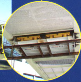
浦东机场II号航站楼登机桥采用GERB-TMD技术控制乘客行走激振，振动衰减70%以上。
