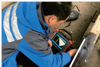
钢轨焊缝检测
