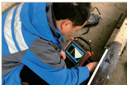
钢轨焊缝检测
