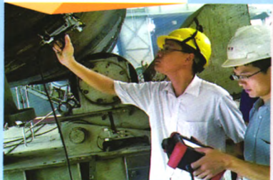
压力容器焊缝检测
