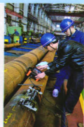
压力钢管检测
