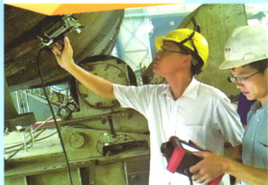
压力容器焊缝检测
