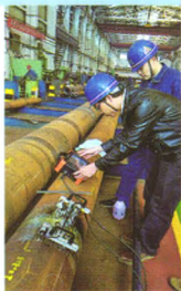
压力钢管检测
