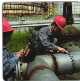
管道环焊缝检测
