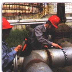
管道环焊缝检测
