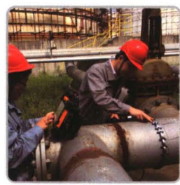
管道环焊缝检测
