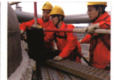
不锈钢容器焊缝检测
