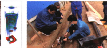
PE管道焊缝检测
