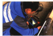
钢轨焊缝检测
