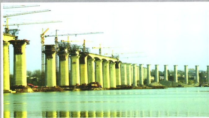
嘉陵江特大桥墩身施工
