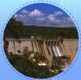
柬埔寨甘寨水电站
