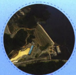
马来西亚巴贡水电站
