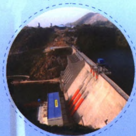
加纳布维水电站
