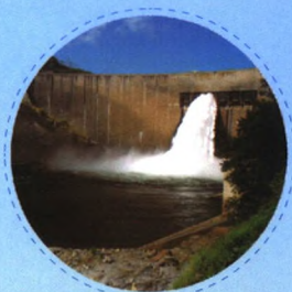
赞比亚卡里北岸扩机工程
