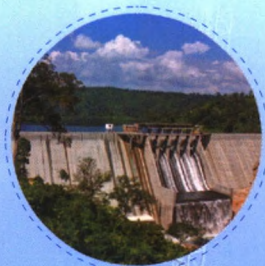
柬埔寨甘寨再水电站
