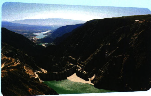
黄河拉西瓦水电站
