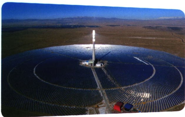
中电建青海共和50兆瓦塔式光热发电项目
