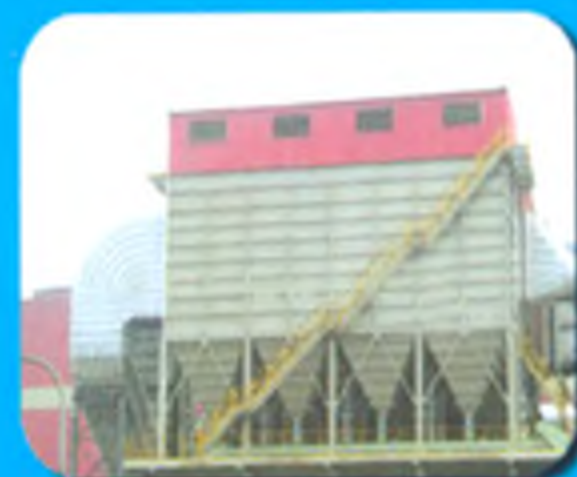
KLMC低压脉冲长布袋式除尘器
