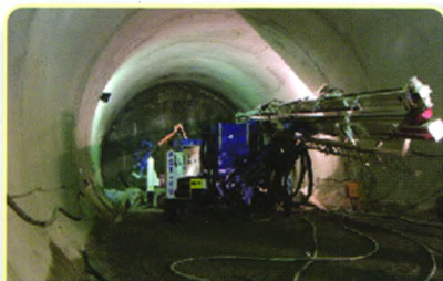
隧道水平旋喷施工
