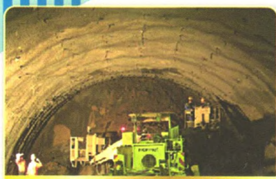
隧道非爆破开挖施工
