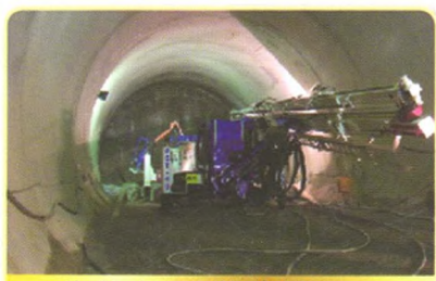
隧道水平旋喷施工
