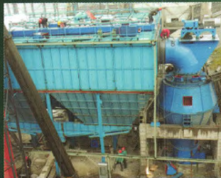
系统改造现场
