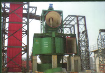
改进型选粉机安装现场
