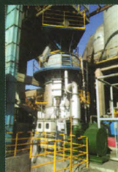
煤立磨改造现场
