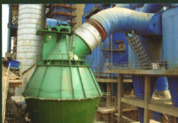
生料立磨改造现场
