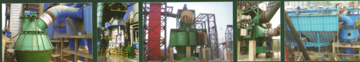
生料立磨改造现场
